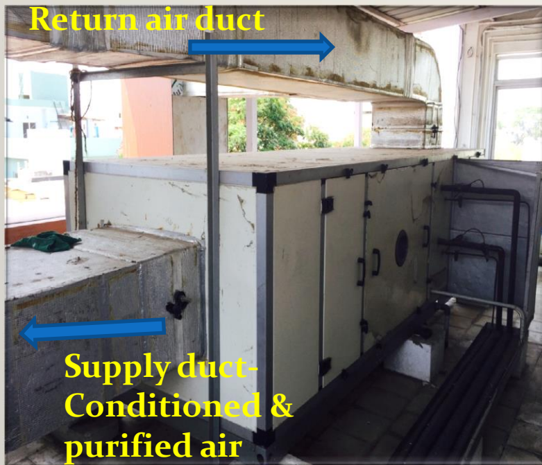
Air Handling Unit(AHU)
